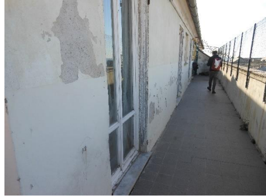
Figura 4.1 - Particolare della porzione di involucro esterno
