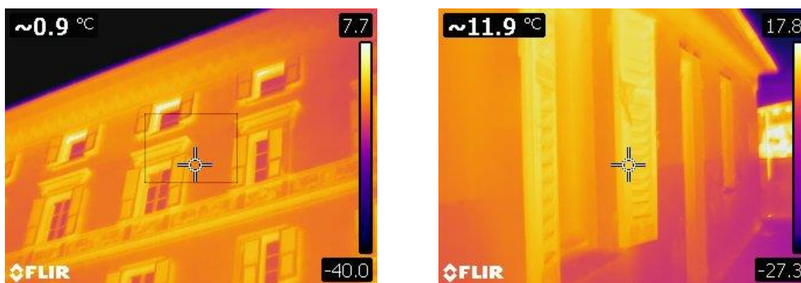
Figura 4.5 – Rilievo termografico dei serramenti
