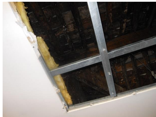
Figura 4.2 - Particolare della copertura
