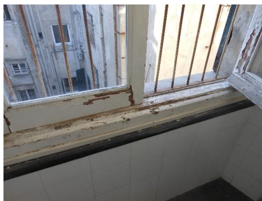
Figura 4.4 - Particolare dei serramenti
