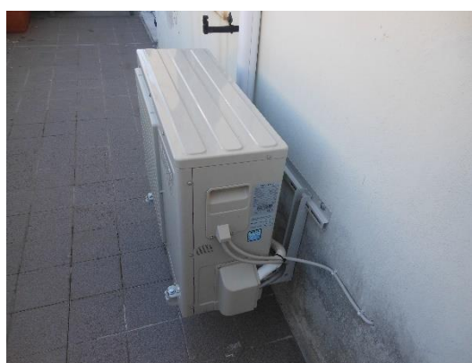
Figura 4.14 - Particolare di un sistema dualsplit
