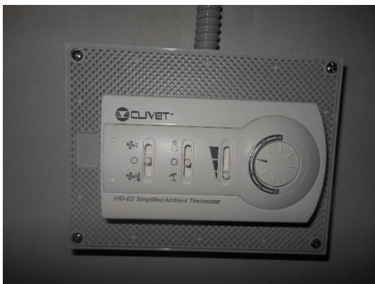
Figura 4.9 - Particolare del termostato di zona
